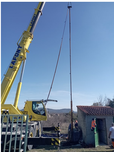
Profondeur 146,45 m Tubage perforé par la corrosi fragile dans cette zone.
